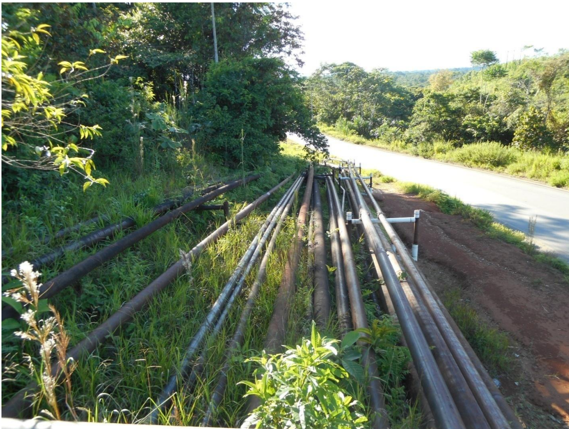
Vista de una enramada de tubos de acero que transportan petróleo, muy común verlos en las carreteras. Este pertenece muy cerca del camino rumbo a la Finca RICAMA
