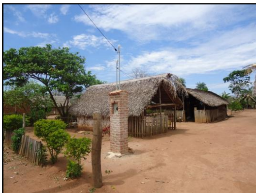
CIPCA: Domicilio con pilastra y bastones para el acceso a la energía eléctrica
