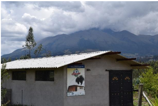
Centro de Acopio de Leche
