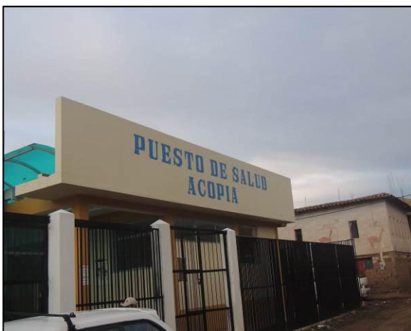
Nuevas instalaciones del puesto de salud en Acopía
